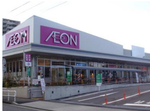
東海地方店舗 2015年6月施工
