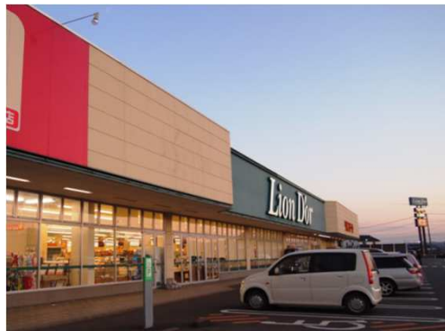
栃木県内店舗 2015年12月施工
