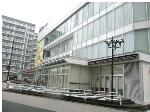
岐阜県内店舗 2015年9月施工
