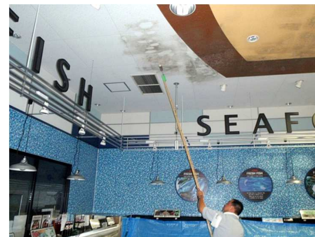
カビ除去作業
