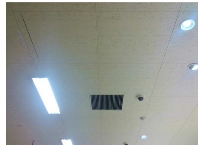
施工後は新築時に近い状態が長期間維持されます
