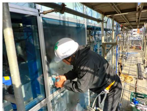
②研磨作業：汚れを落とし、専用研磨剤とサンダーで表面を磨きます
