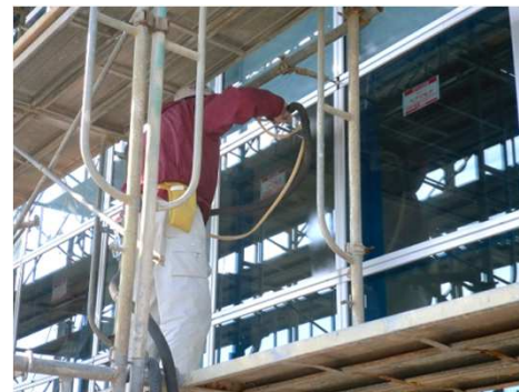
④光触媒コーティング：専用噴霧器で効率的に施工します
