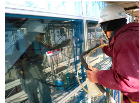
④光触媒コーティング：専用噴霧器で効率的に施工します
