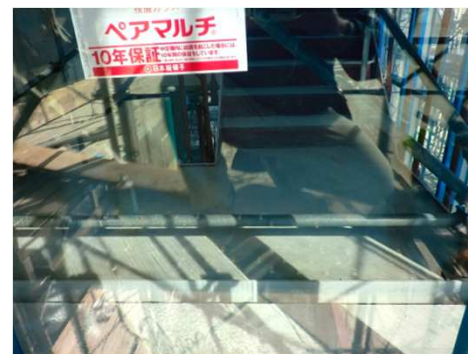
③研磨後：ガラス表面の凹凸がなくなりキレイな親水状態になっています
