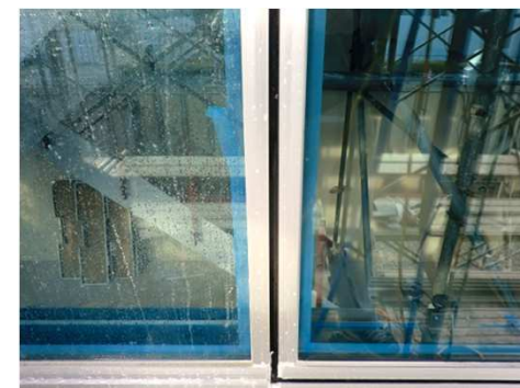
③研磨後：ガラス表面の凹凸がなくなりキレイな親水状態になっています
