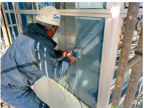
②研磨作業：汚れを落とし、専用研磨剤とサンダーで表面を磨きます
