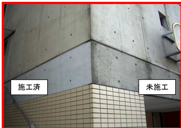
未塗装面に一部光触媒施工
