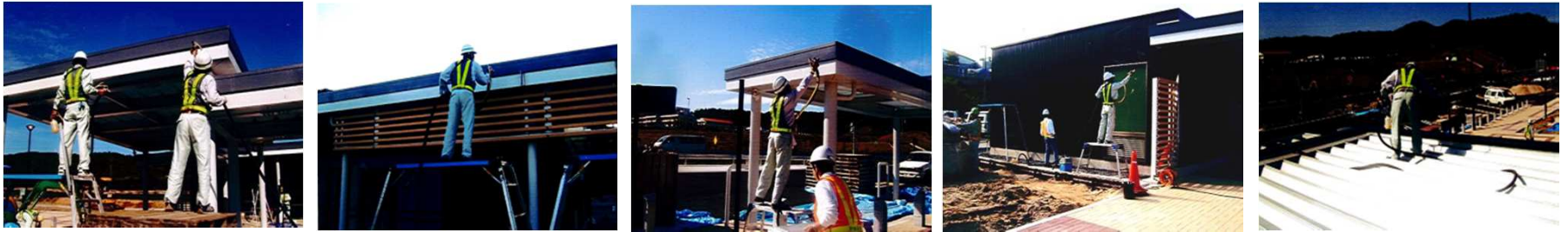
東海環状線 五斗蒔PA (岐阜) 2008年8月
