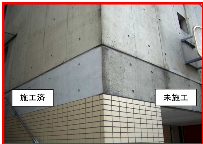
未塗装面に一部光触媒施工
