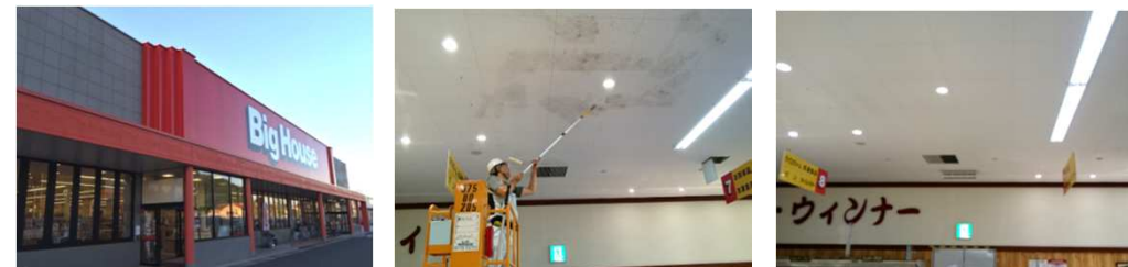
宮城県内店舗 2015年8月施工
