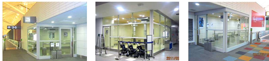
中部国際空港の喫煙室12室施工(2011年3月)
