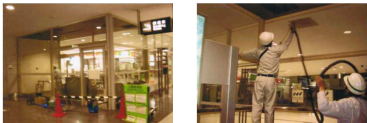
中部国際空港の喫煙室7室施工(2008年4月)
